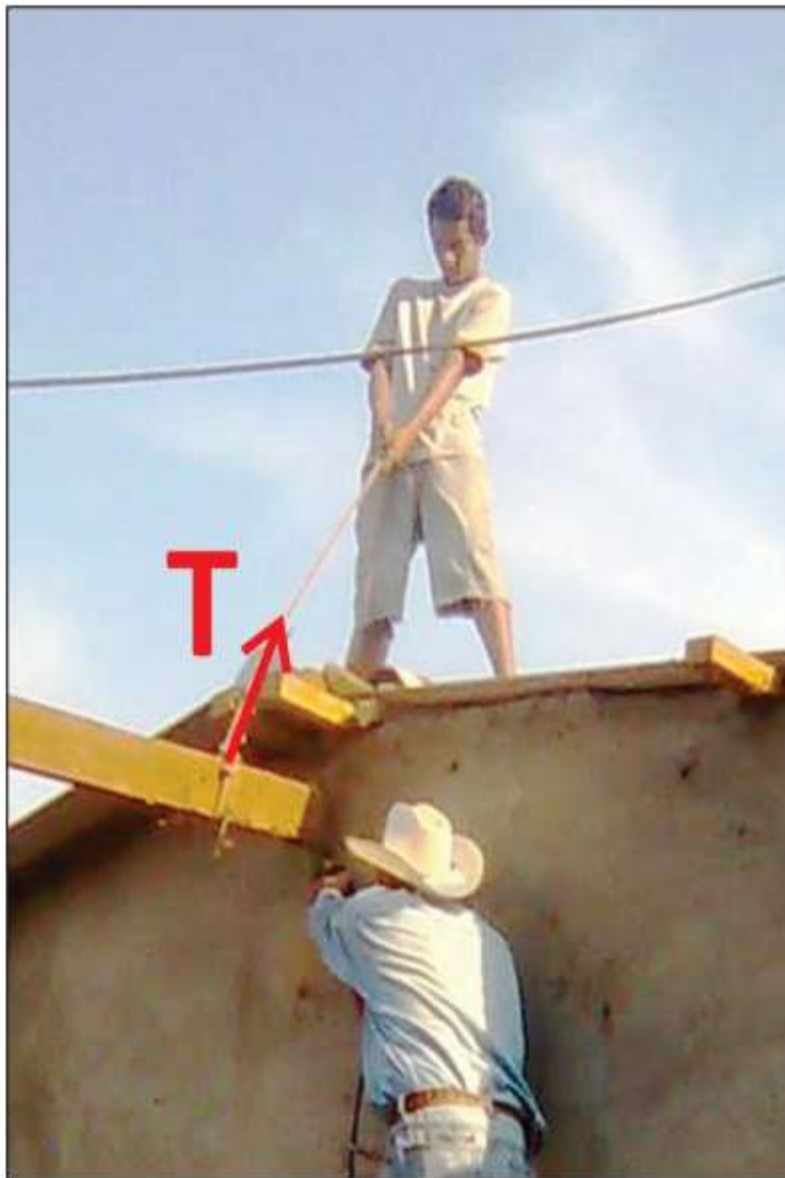
Figura 3. El lazo atado a la viga genera una fuerza de tensión al ser halado por el trabajador.
